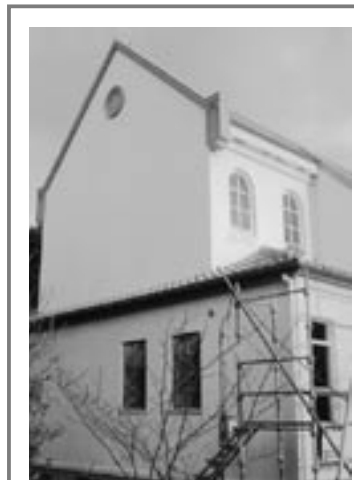
ザビエル旧聖堂の進捗状況 聖堂背面が完成(1月20日) 祭壇に光を入れる窓が見える。外観は砂漆喰。
