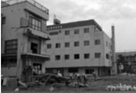
④壊滅的な大槌町の様子
