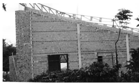
建設が進む聖堂
