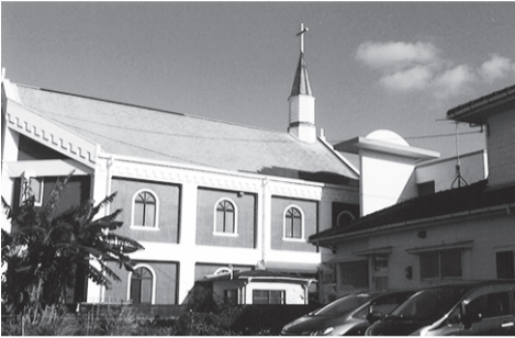
①聖堂内の壁画の前で喜びの信者たち ②外壁、屋根の修理が終わった教会
